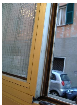
Figura 8.1 – Particolare dei serramenti esistenti
