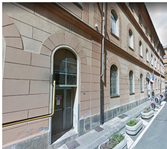
Figura 1.1 - Vista della facciata Sud-Est
