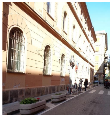
Figura 4.1 - Particolare facciata ovest fabbricato
